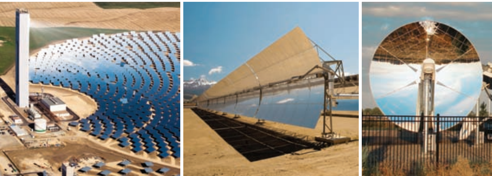
PHOTOS DE GAUCHE À DROITE Trois différents types de centrales solaires thermiques : tour solaire, capteurs cylindro-paraboliques, et concentrateurs paraboliques.
